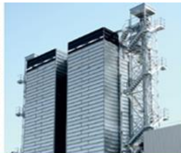
Полностью теплоизо- лированная шахта
