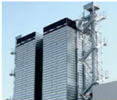
Полностью теплоизо- лированная шахта
